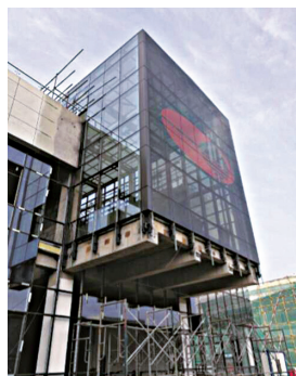
图 13 国家大剧院舞美中心艺术交流楼 (超大 CdTe 薄膜透光组件的应用)
