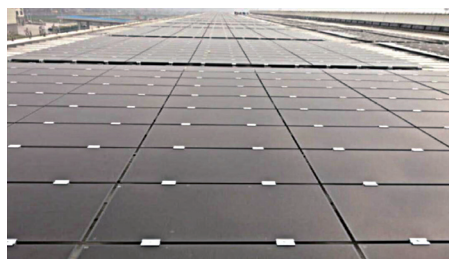
图 12 宁波兴港货柜 MW 级分布式碲化镉薄膜光伏电站
