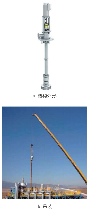
图1 熔盐泵的结构外形和吊装情况
