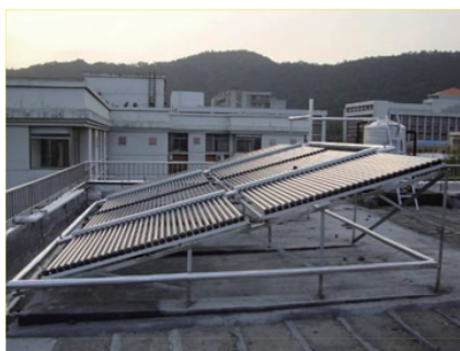
图5 新型太阳能热泵室外太阳能集热子系统
