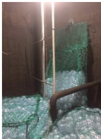
图3 相变蓄冷球及其在水罐内的施工图
