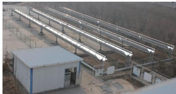
图1 槽式太阳能集热器阵列
