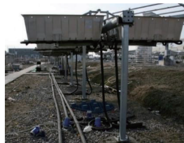
图7 FHCPV/T管路连接
